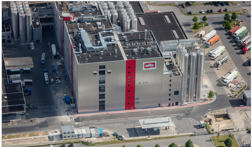
El edificio del área “Molke 5” de Sachsenmilch
