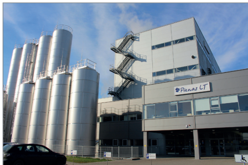
Neubau der Pienas Molkerei in Kaunas.
