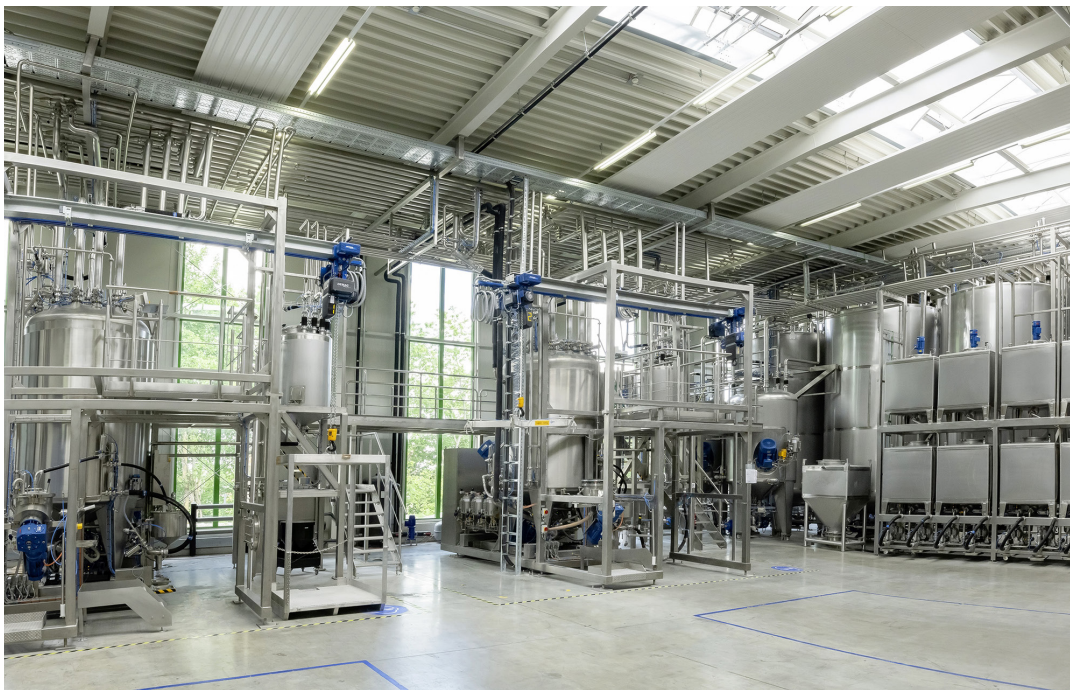
Fertigungsanlage bei Weilburger
